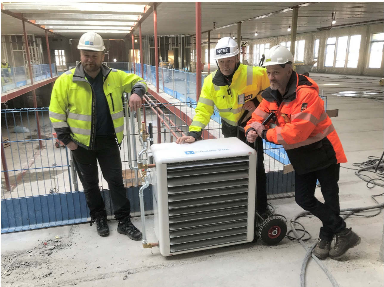
Mobil varmevifte i drift. F.v. Bjørn Peder Andersen (Brødrene Dahl), Pål Høsøien (HENT) og Morten Sund (Mo Fjernvarme). Foto: Mo Fjernvarme AS
