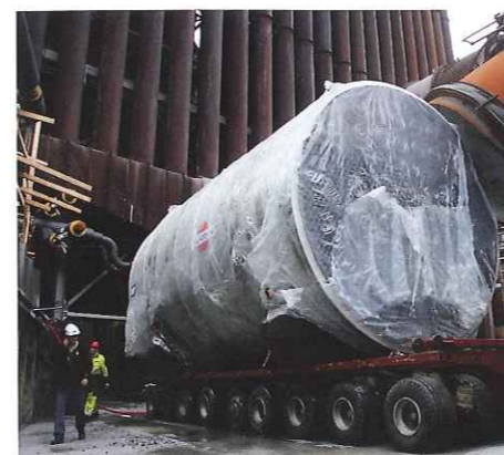
Den nye kjelen ble transportert på plass og sto klar for montering i slutten av september 2011. Foto: MIP-Info.
