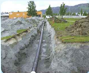
Stadig nye områder knyttes til fjernvarmenettet i Mo i Rana.
